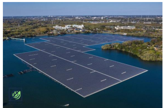
شکل (۱): نیروگاه خورشیدی شناور از کاربردهای پدیده فتوولتائیک
